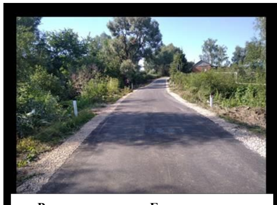
Ремонт дороги в с. Берендеевка – д. Волчиха
