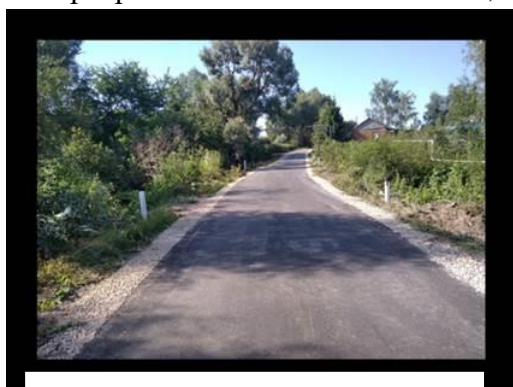
Ремонт дороги в с. Берендеевка – д. Волчиха
